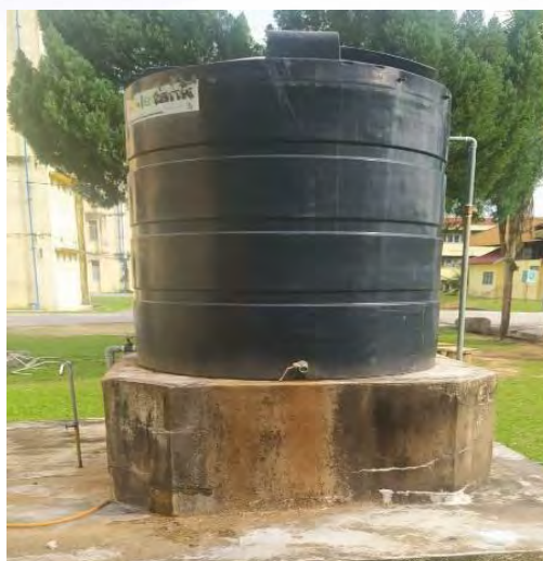
Rajah 1. Tangki Simpanan Air Hujan di Blok A Kamsis Al- Biruni, POLISAS
